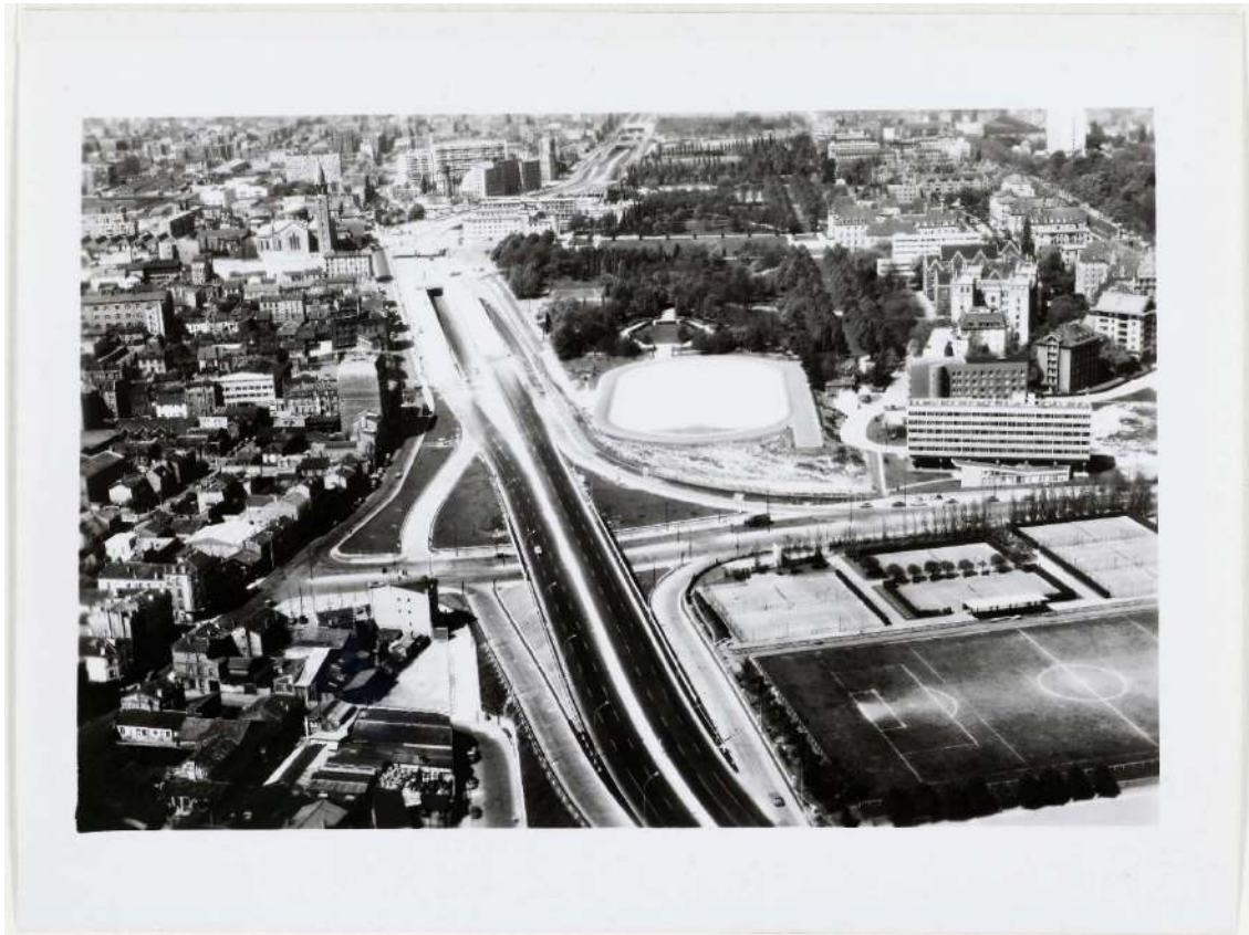
Vue aérienne vers l'ouest du boulevard Périphérique en construction vers 1961. À droite, la Cité universitaire. Roger Henrard photographe. © Musée Carnavalet.
