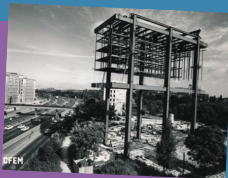
Montage de la structure porteuse de la Fondation Avicenne, 1967
