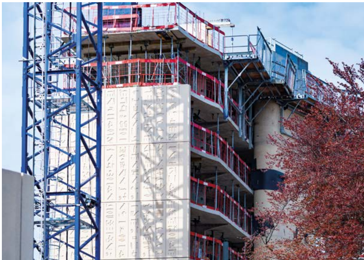
Les travaux de la Maison d'Égypte ont démarré en 2021. Gravée d'anciens textes égyptiens, traitant de la quête du savoir, la façade en béton ocre s'inscrit dans l'esprit minéral et monolithique des constructions égyptiennes.
